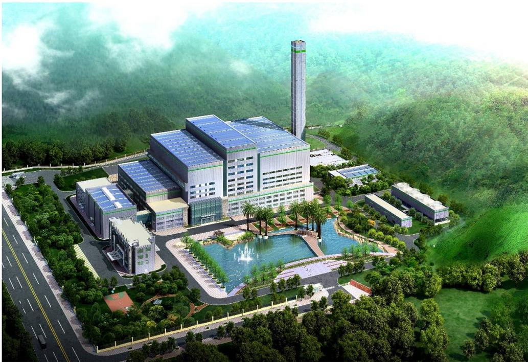
本项目设计总规模为 1500t/d 生活垃圾焚烧处理能力，配置 1 台 25+10MW 汽轮发电机。分二期建设，即本期设计规模为 1500t/d，建设一条 2×500t/d 生活垃圾焚烧线，配置 1 台 20MW 汽轮发电机；预留二期扩建规模为 500t/d，扩建 1 条 500t/d 焚烧线和 1 台 9MW 凝汽式汽轮发电机组。
