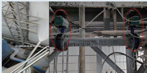
玉田焚燒：煙氣脫酸工藝改造
